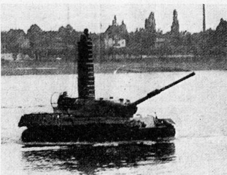
Kommandanten als Ausblick dient. Die weißen Markierungsstriche beginnen bei 2,6 m über der Turmoberkante und enden bei 5 m Eintauchtiefe. Ein tieferes Tauchen ist für Panzer kaum möglich, weil der Auftrieb die Bodenadhäsion aufhebt, so daß der Antrieb nicht mehr gewährleistet ist.
