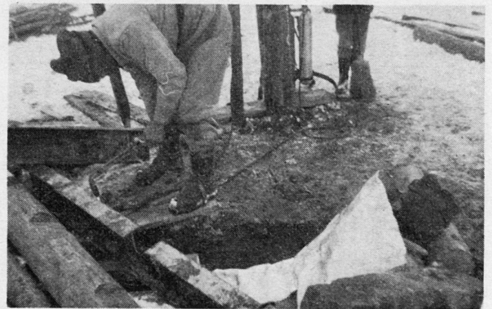
Bild 9. Schneiden über dem abgedeckten Verwundeten mit autogenem Schneidgerät.
