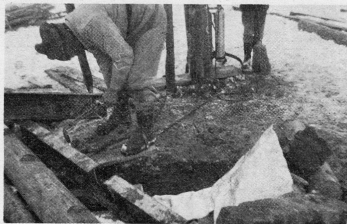
Bild 9. Schneiden über dem abgedeckten Verwundeten mit autogenem Schneidergerät.
