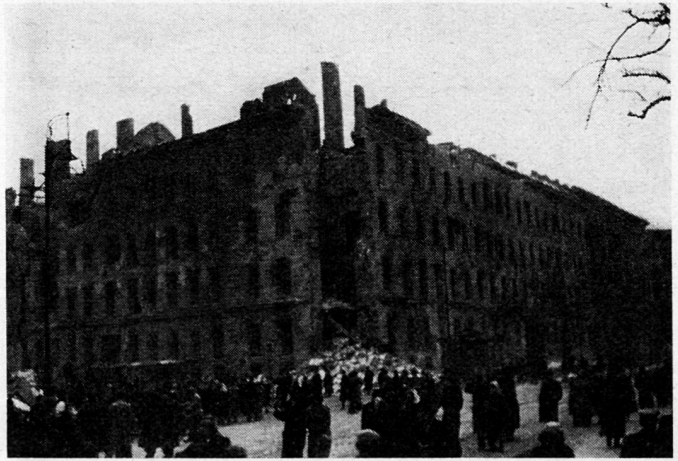
Abb. 2. Die völlig ausgebrannte Kilián-Kaserne nach der zweiten sowjetischen Militärintervention in Budapest am 4. November 1956 (Aufnahme des Verfassers)
