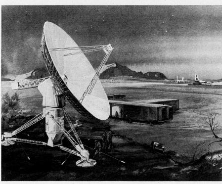
Typische Installation einer Mark-I-B-Relaisstation. Vorn links die Antennenanlage, in der Bildmitte die drei Kastenwagen mit der elektronischen Ausrüstung, dahinter die drei Stromversorgungsaggregate. Rechts hinten Verlad einer Anlage in Transportflugzeuge.
