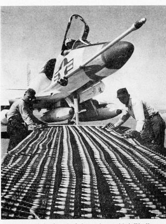
Bild 1. A4 «Skyhawk» mit drei montierten «Mark-IV»-Kanonenbehältern und derjenigen Menge von Geschossen, welche einem Feuerstoß von 4 Sekunden oder rund einem Drittel der gesamten Munitionsausrüstung entspricht.
