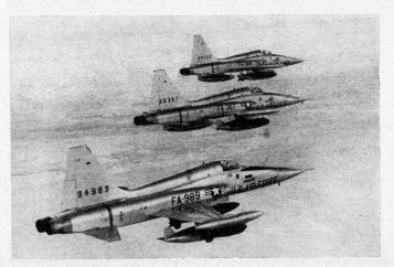
Die F5 verfügt über zwei Triebwerke General Electric J85–13 mit Nachbrenner und einem Schub von 3628 kg, erreicht eine Höchstgeschwindigkeit von 1600 km/h und eine höchste Flughöhe von 16400 m ü. M. Die Steigfähigkeit beträgt 9144 m/min auf Meereshöhe.
