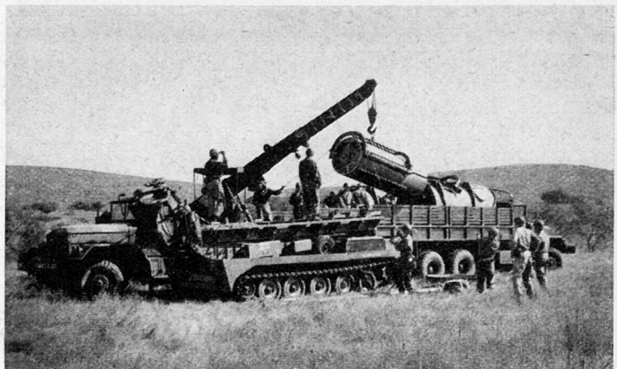
Eine nachgeschobene Rakete wird im Einsatzraum zusammengesetzt
