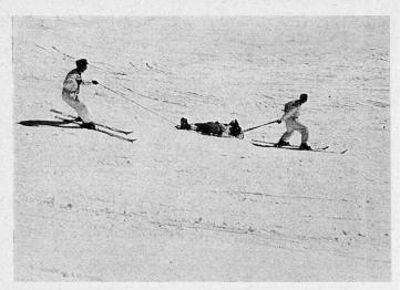
Bild 6. Verwundetentransport auf Notschlitten (Skier des Verletzten, verbunden durch modifizierten Dufour-Gaillard)
