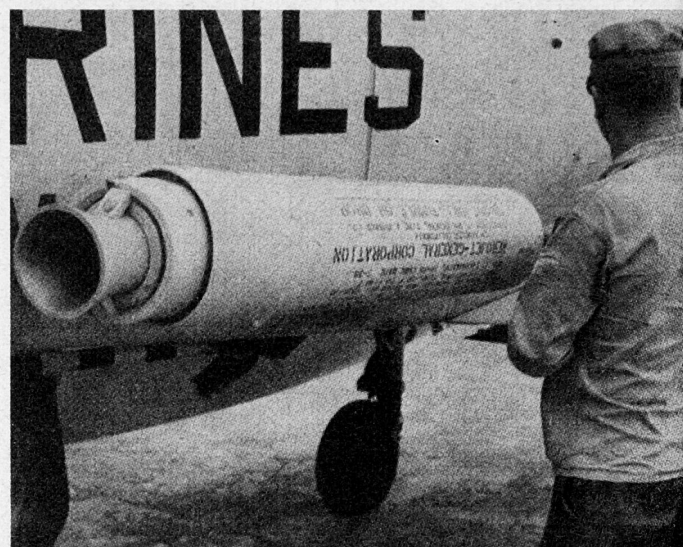
Bild 6. Oben: ein A 4 D der amerikanischen Marine startet mit Jato-Raketen. Man beachte die langen Stichflammen links und rechts des Flugzeuges. – Unten: Installation der Jato-Raketen auf dem A 4 D. Man sieht, daß bereits für relativ kleine Schubleistungen die Dimensionen dieser Raketen beträchtlich sind
