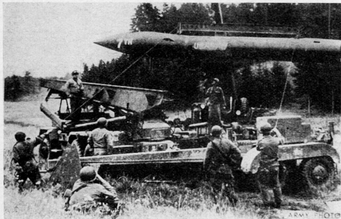
«Honest John». Erstellen der Schußbereitschaft. Im Vordergrund steht der Transportanhänger. Rechts der Kranwagen und links das Gerätefahrzeug mit der Rampe
