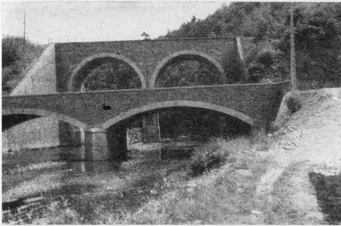
Straßen- und Eisenbahnbrücke über die Amblève nordöstlich Trois Ponts
