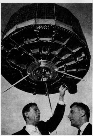
Fig. 7. Ansicht des Wettersatelliten Tiros I von unten In der Mitte die Objektive der Fernseh- und Weitwinkelkameras; strahlenförmig darum herum angeordnet die Ruten der Sendeantennen. Gürtelförmig aufgebracht ein Teil der 9300 Zellen der Sonnenbatterie für die Erzeugung der elektrischen Energie
