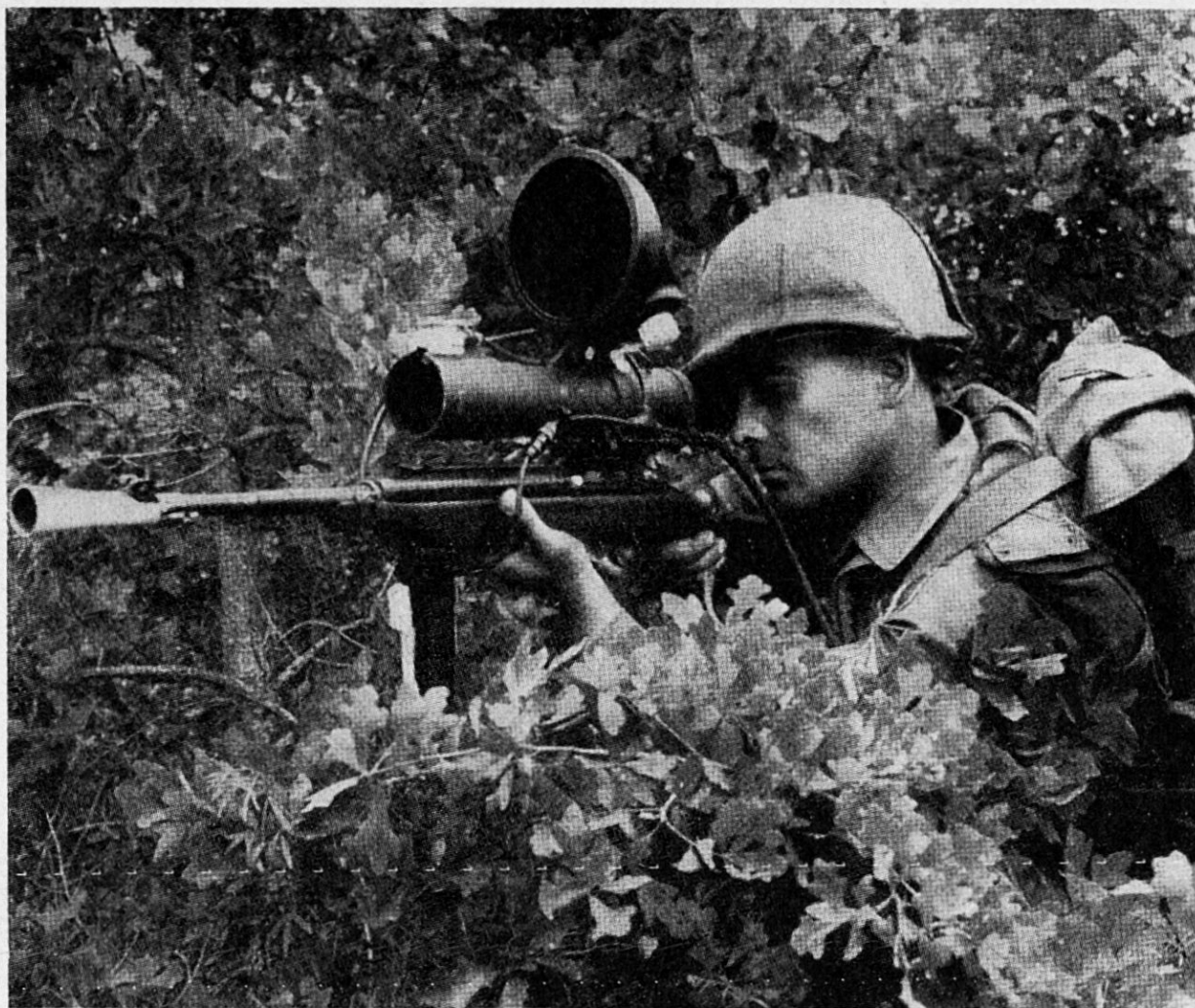
Fig. 1. Ein Infrarot-Gerät auf den direkt schießenden Infanteriewaffen erlaubt, in einem beschränkten Winkelbereich ein Ziel zu erkennen und damit zu zielen. Die Reichweite dieses neuen Gerätes ist erheblich größer als diejenige der gegenwärtig verwendeten Infrarotvisiere. Das Gerät kann auch die Verwendung von Infrarotgeräten beim Gegner feststellen, unterliegt aber selber auch diesem Nachteil. Pro Füsilierzug und Stab soll ein Gerät abgegeben werden.
