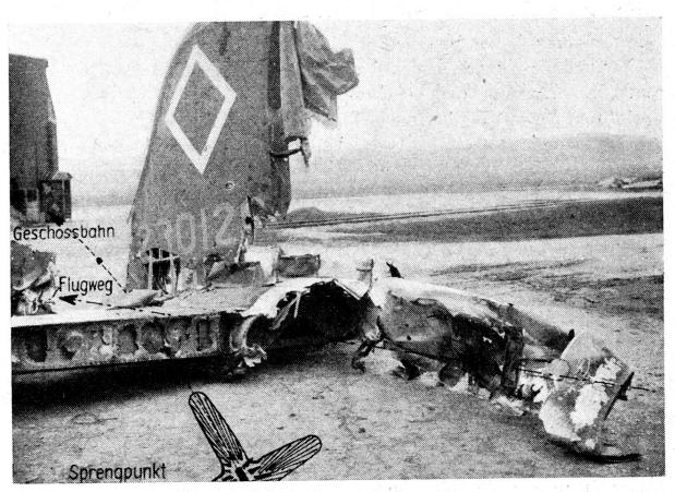
Abb. 1. Wirksamer 7,5-cm-Flabtreffer in Flugzeugnähe. Mit eingezeichneter Geschoßbahn, Flugweg und Splitterverteilung.
