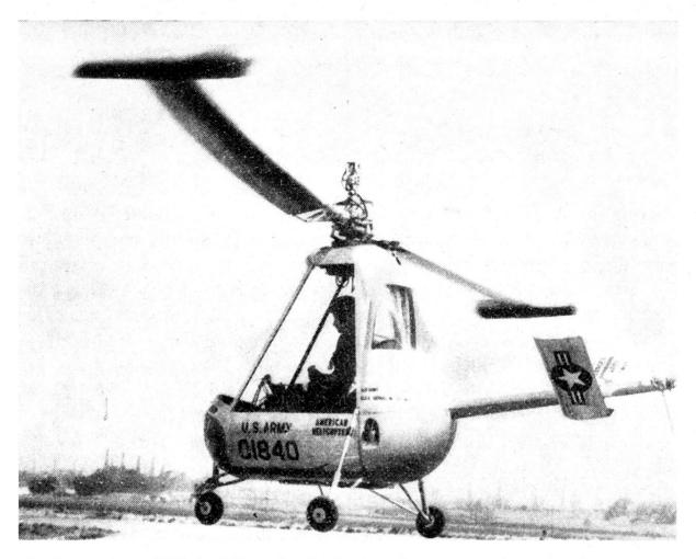
La Jeep volante XH26 Hélicoptère à réaction; à remarquer les pulsoréacteurs au bout des pales du rotor. Le poids de cet appareil est de 130 kg
