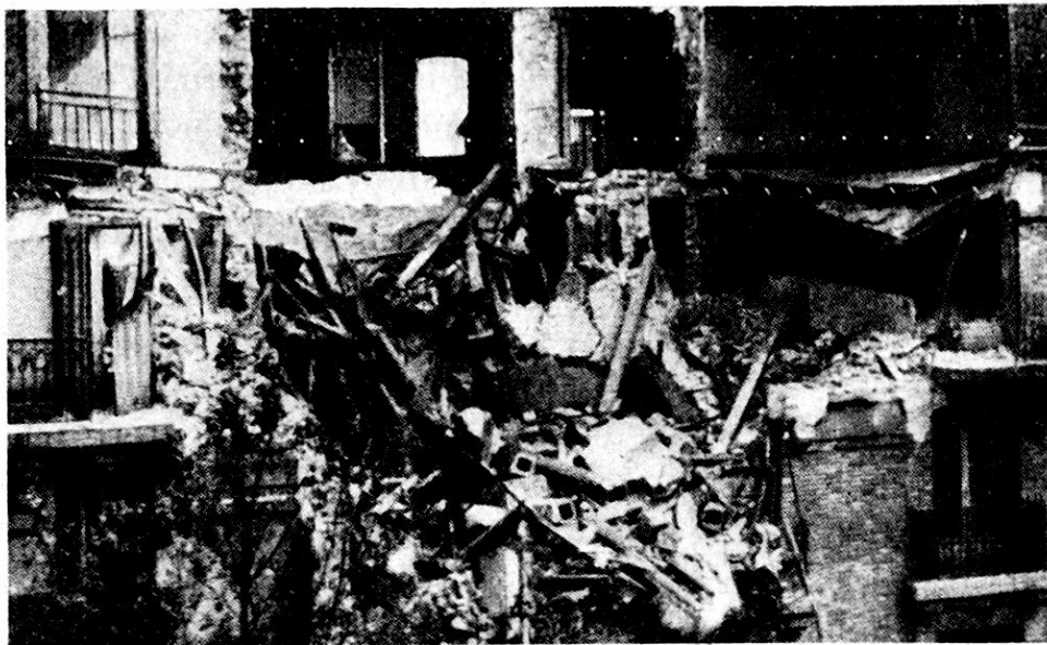
Abb. I. Zerstörungen an Häusern durch Geschößeinschläge der Pariskanone in Paris
