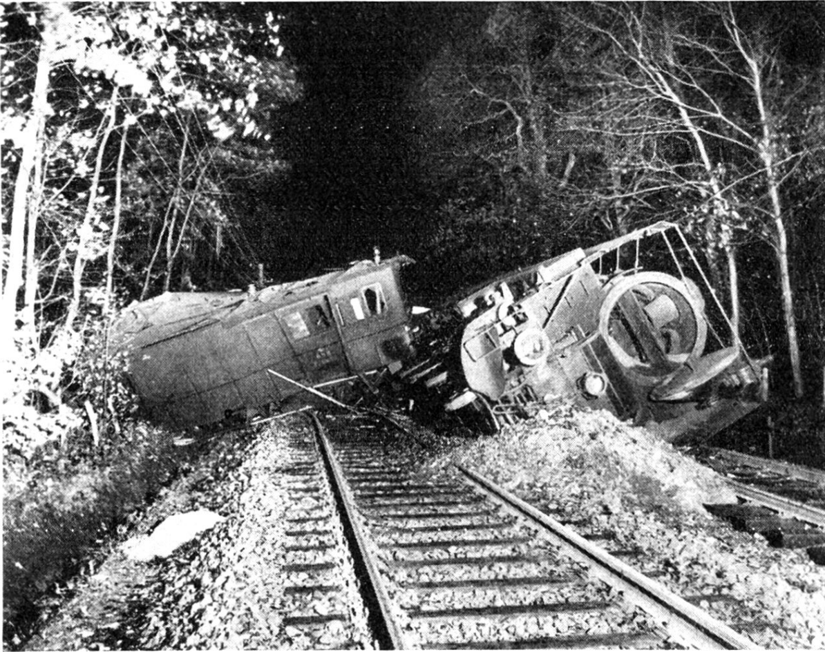
Auswirkung einer Geleisesprengung bei Espergaerde im November 1942
