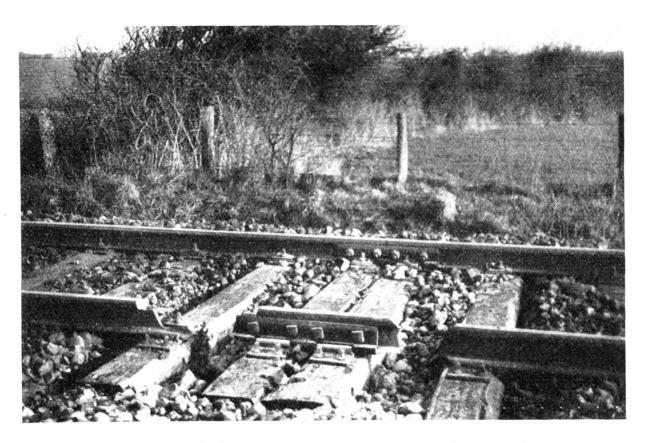
Ungenügende Sprengung mit zweimal 224 gr Sprengstoff
