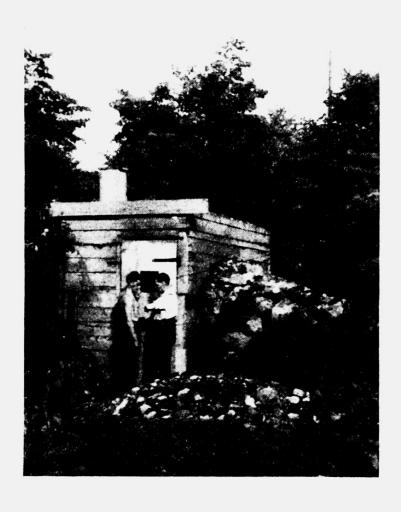
hauses: 4 m lang, 2 m breit, 2,5 m hoch. Drei Zimmerleute aus dem Bat. San. Z. besorgten in einer mechanischen Zimmerei des nahen Städtchens in zweitägiger Arbeit die Zurichtung des Holzes. In 2 Rahmen aus 20 cm starken Gerüstbalken wurden die 10 cm dicken Flecklinge eingelassen und mit einer Zwischenschicht von trockenem Moos gut gegeneinander abgedichtet. Decke eine einfache Lage von Flecklingen gleicher Dicke. In der Vorderwand seitlich eine Türe von 60 cm Breite mit Fenster im
