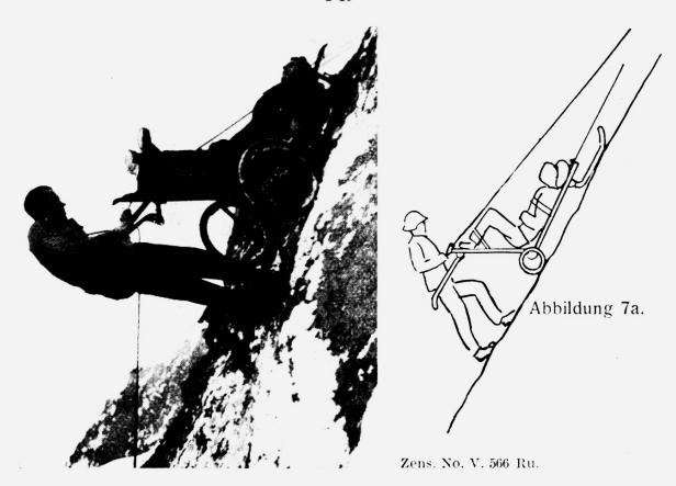
Abbildung 7. Am Abseilfelsen. (Die eingeschwenkten vorderen Holme werden mit einem Riemen verbunden, dadurch entsteht ein Schlaufensitz für den Führer.)
