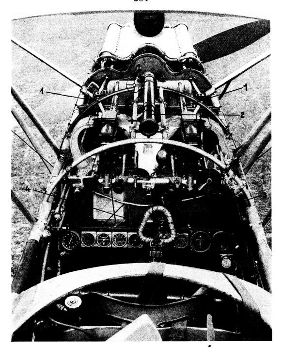
Einbau der Piloten-Mg. im Flugzeug 1 Mg. für Pilot 2 Visier 3 Abzug 4 Munitionskasten
