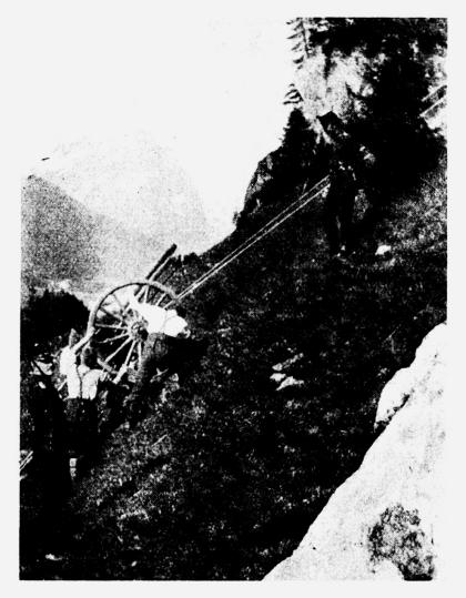
Abb. 5: Handseilzug eines abgeprotzten Geschützes bei 100 % Steigung.
