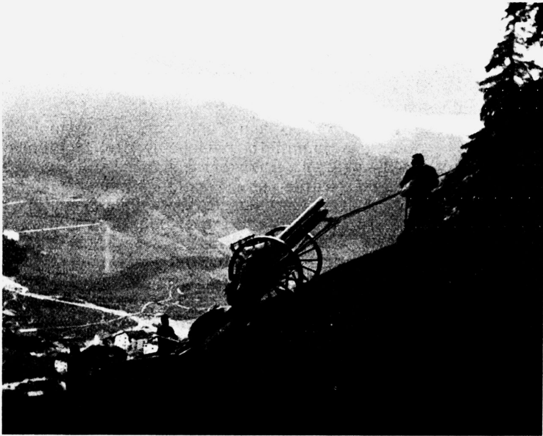
Abb. 1: Aufzug eines abgeprotzten Geschützes mittels Seilen und Pferdezug.
