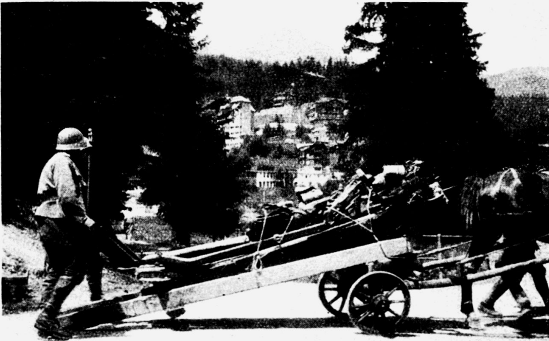
Abb. 7: Improvisiertes Lafettenfuhrwerk, Bündner Vorwagen mit Schleifbaum.
