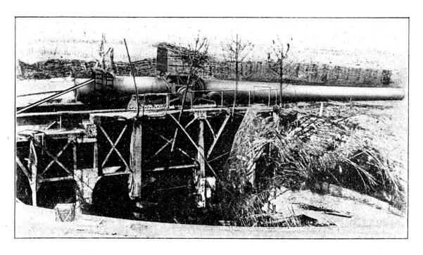
Abb. 9 = 380 mm Kanone, Batterie Deutschland, auf eingelassener Plattform, camoufliert.
