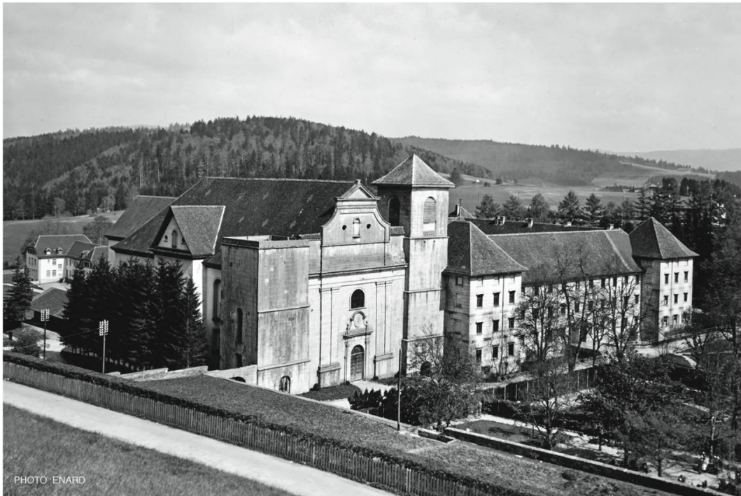
Fig. 7: Bellelay, l'abbaye vue du nord-ouest (photo F. Énard, Delémont).
