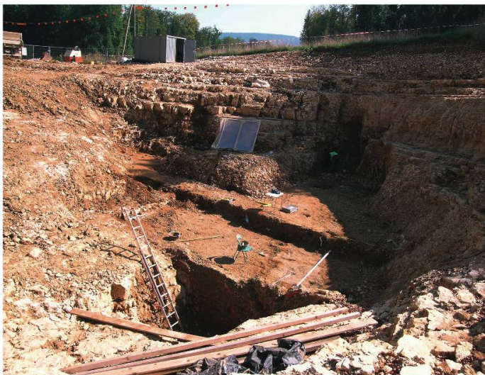
Fig. 4: Photo du chantier de Béchat Bovais, devant la première coupe verticale de l'axe A-B et derrière la deuxième coupe de l'axe P-Q. Photographie Gaëtan Rauber © OCC-SAP.
