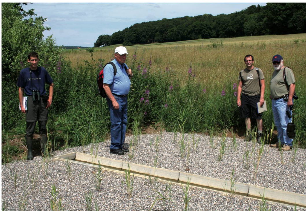
Fig. 9. Le président de la FMD et les «concepteurs» de Biotec et Aménat inspectent le bassin de décantation et de filtration, planté de jeunes roseaux, 10.06.09. Photo: Philippe Bassin.
