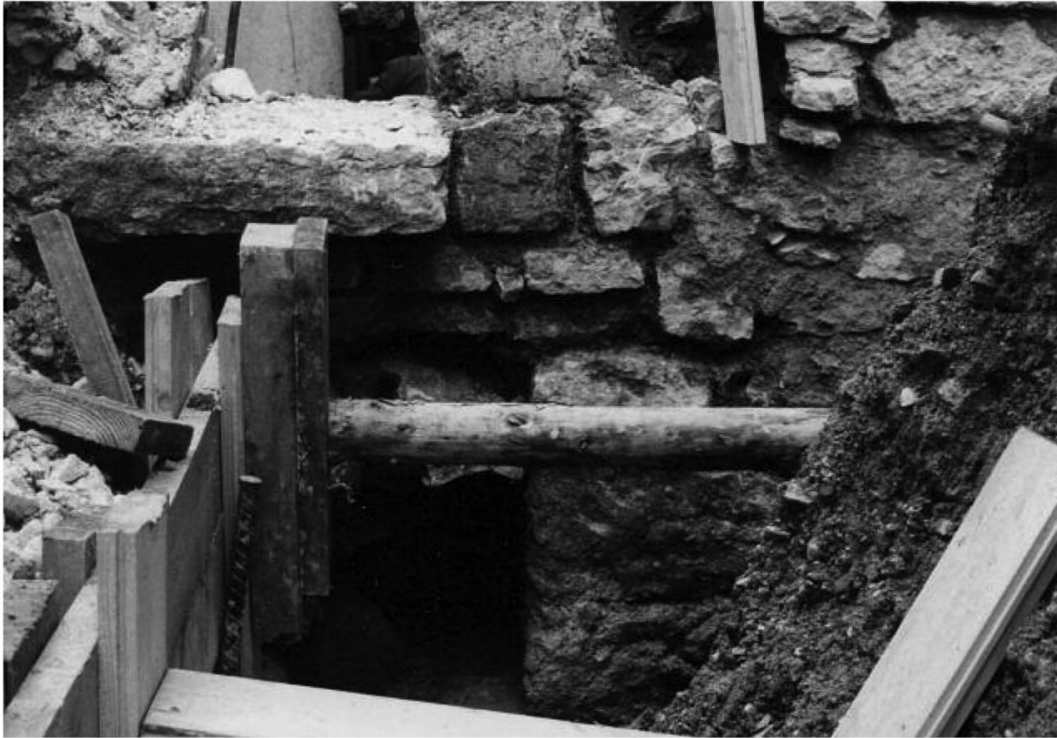
Fig. 6 : Vue de l'angle sud-ouest de la maison-tour primitive. On distingue en bas la chaîne d'angle du XII e siècle et en haut l'amorce du mur sud de l'extension gothique, ainsi que le seuil de sa porte d'entrée. (Photo: C. de Reynier)
