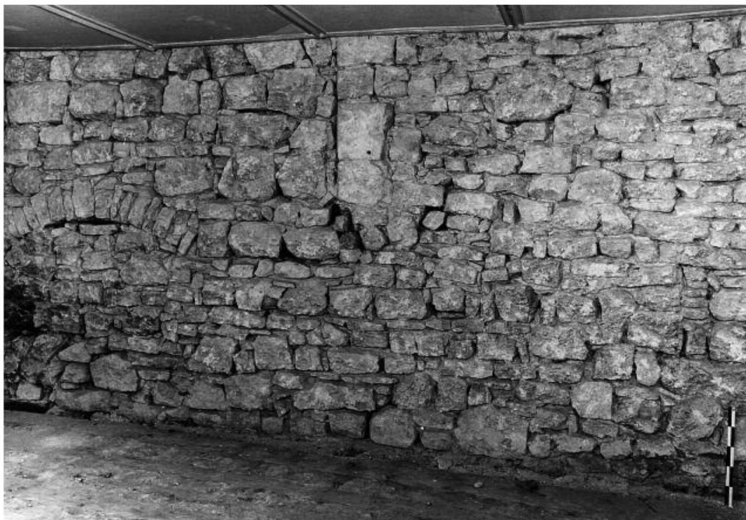
Fig. 4 : Traces d'ouvertures et de planchers médiévaux dans le parement intérieur du mur nord de la maison rebâtie en 1782. (Office de la Culture du Canton du Jura, section d'archéologie)
