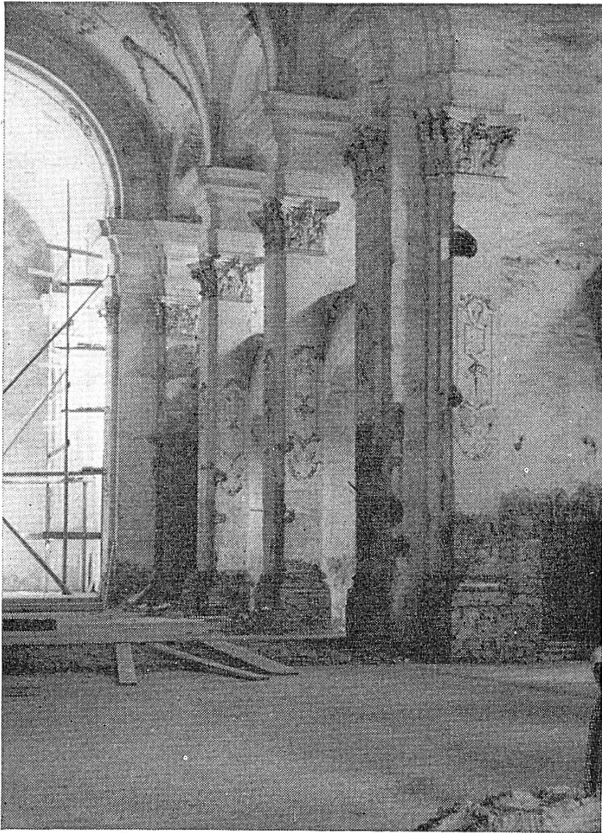
Vue du chœur des moines avec à gauche le sanctuaire et à droite l'ouverture du transept
