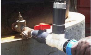
Fig. 3: Deux doseurs de chlore automatiques fabriqués à partir de matériaux locaux et bon marché.
