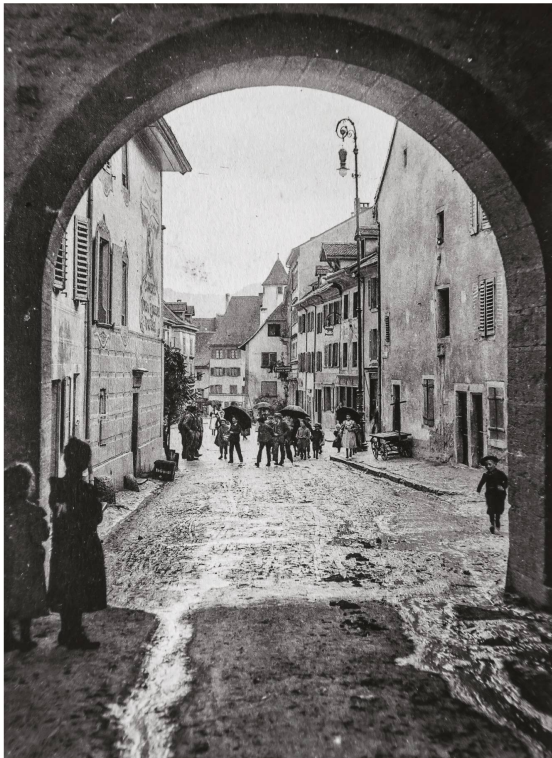
Ill. 08 : Delémont, Café d'Espagne, vue depuis la Porte au Loup. (Source: fonds Pierre Tschopp)
