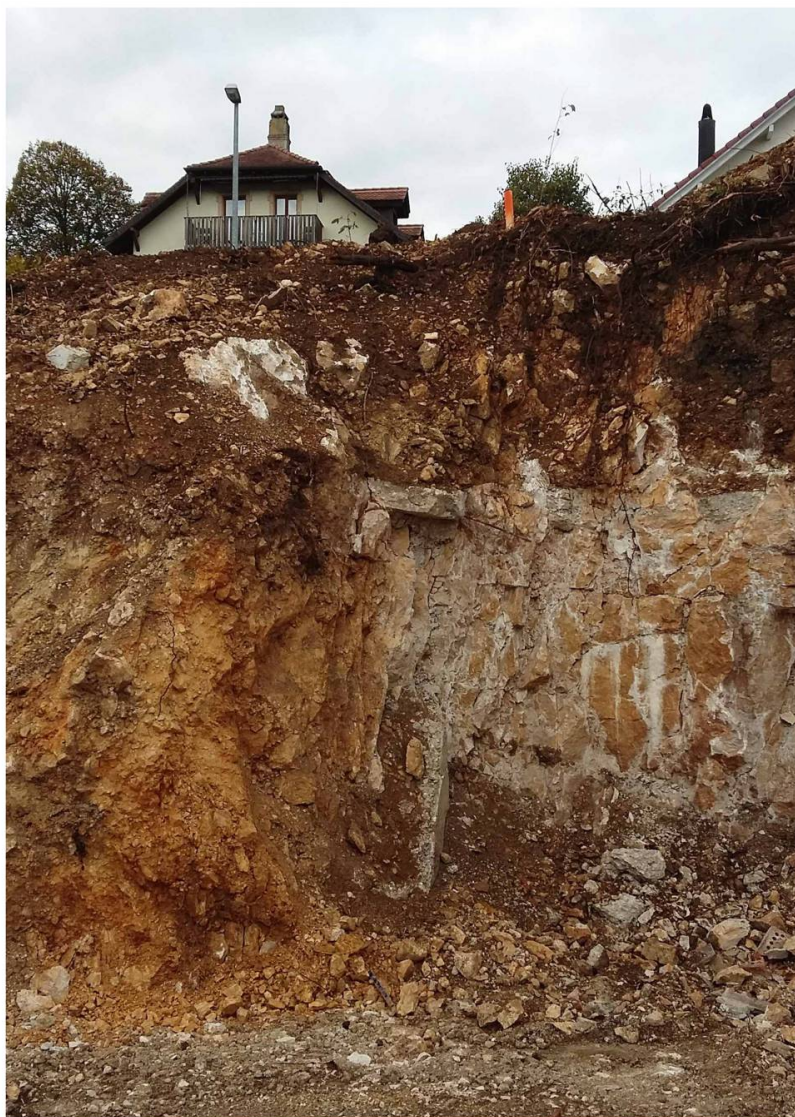
Fig. 3: Paquet glissé du nord de la rue de Chêtré, calcaires fracturés à pendage horizontal (coordonnées 592 650/246 725). La localisation des objets est donnée en figure 2.
