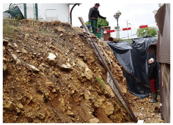
Fig. 8: Talus de la fouille pour le nouvel immeuble à la rue des Vergers (coordonnées 593 515/246 567).
