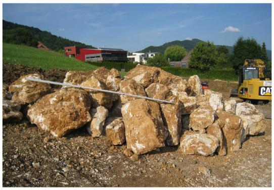
Fig. 9: Blocs calcaires anguleux (Malm) retirés de la fouille à environ 30 m à l'ouest du sentier Henri-Parrat (coordonnées  $593\ 025/246\ 910$ ).
