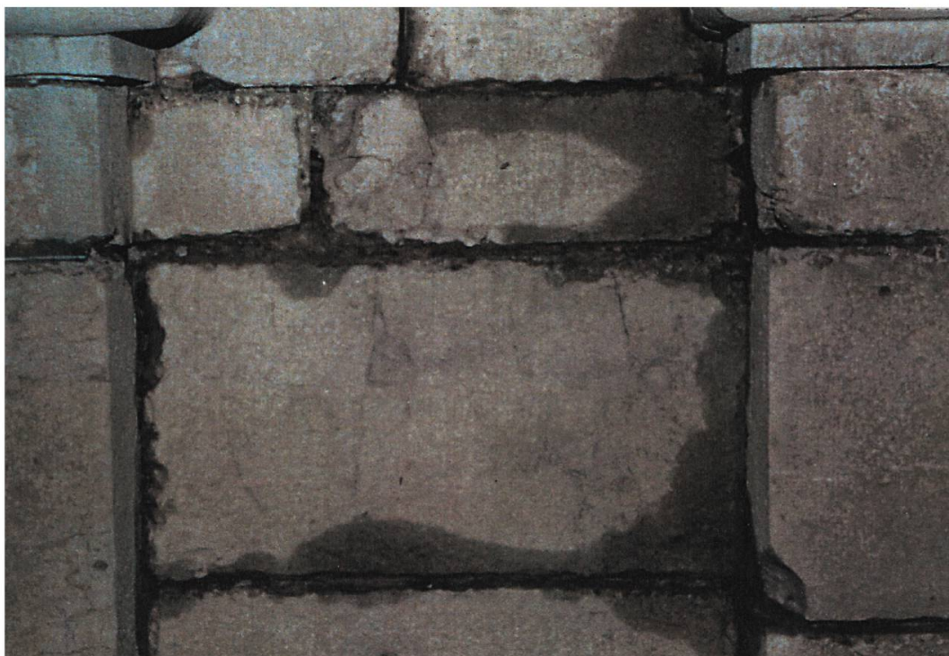
Fig. 9 : Eau coulant des joints ouverts (MHBE).
