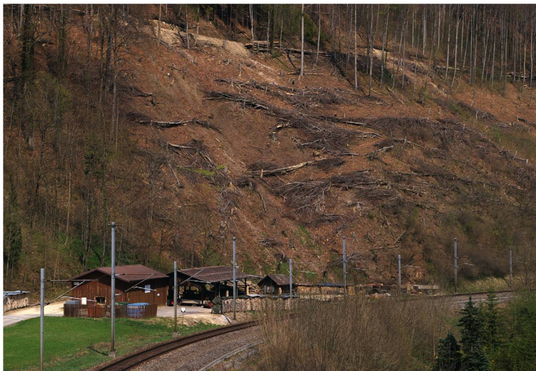
Fig. 22 : Afin de sécuriser la ligne C.F.F., une coupe de bois a été effectuée à Roches, avant la pose d'ouvrages de protection; les souches de hêtres coupés à un mètre et les bois laissés sur place serviront d'hôtes aux Rosalies des Alpes durant plusieurs années. Roches, avril 2009.
