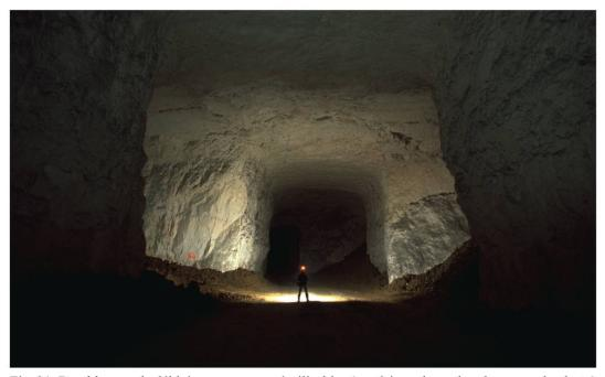
Fig. 21: Remblayage de déblais propres non réutilisables (matériaux de couleur brune sur la photo) dans les galeries des Fours à Chaux.
