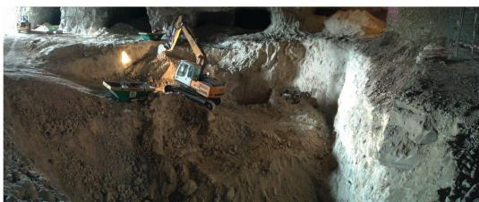
Fig. 20: Images des travaux de nettoyage (boues d'hydroxydes du dépôt Thécla), contrôles systématiques du sol à la pelle, travaux de recreusage et de récupération de déchets dans la grande salle d'entrée.
