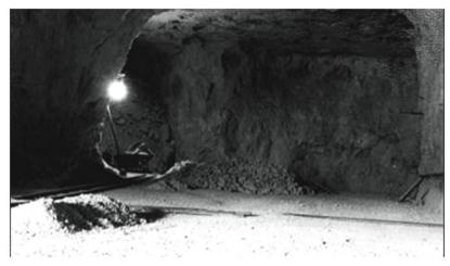
Fig. 10: Galeries en exploitation avec berlines (wagonnets miniers) (photos des années 50).
