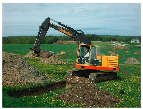
Fig. 8: Sondage réalisé à la pelle mécanique.
