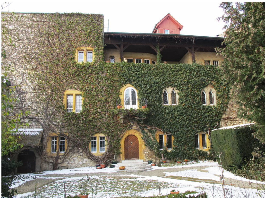
Fig. 2 : La façade donnant sur la cour, état en 2012.
