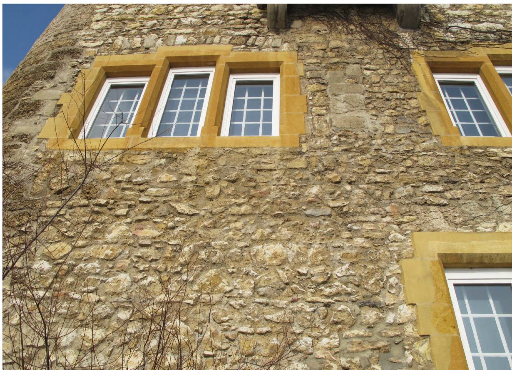
Fig. 15 : Vestiges des fenêtres originales en molasse à côté des encadrements en calcaire d’Hauterive posés en 1930.
