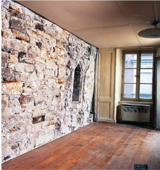
Fig. 20 : Pièce au 1 er étage du bâtiment situé à la rue du Collège 10.
