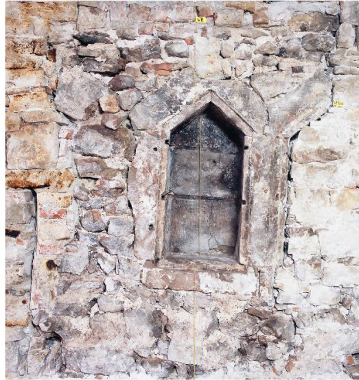
Fig. 21 : Niche à trésor à la rue du Collège 10.
