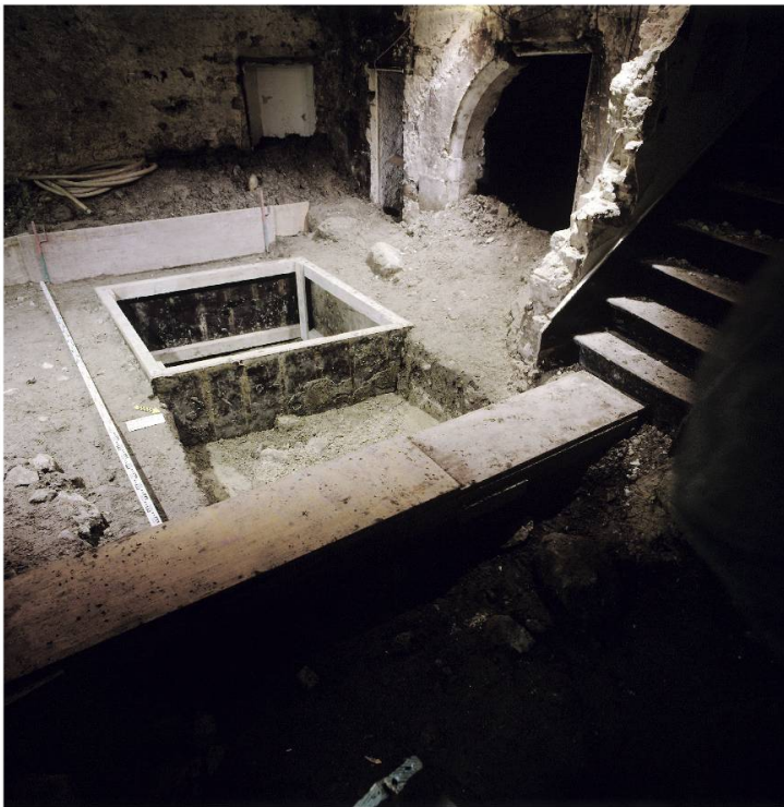
Fig. 5 : Fouilles des fondations du bâtiment situé à la place de la Liberté 2.
