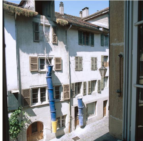
Fig. 13 : Photographie des bâtiments situés à la rue Beaugard 20 et 22.
