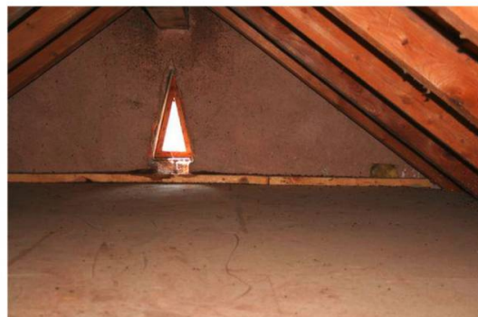
Fig. 8: Abri « propre en ordre » après le nettoyage. La fenêtre en triangle n'est pas ouverte. Les sérotines sortent en dessus, par une petite ouverture vers la panne faîtière que l'on peut voir.
