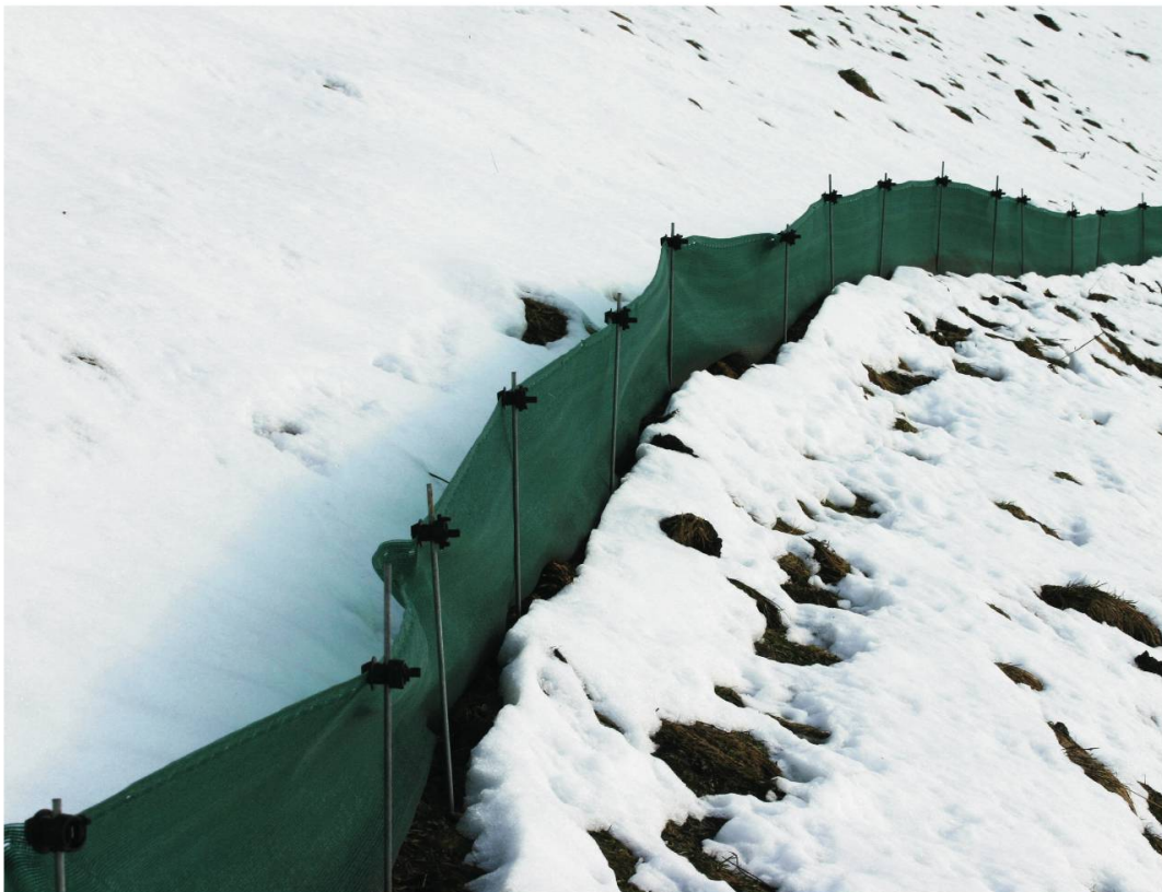
Photo 4 : Filets en place.
