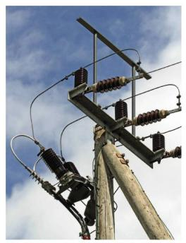
Fig. 36: Protection d'une installation électrique à l'aide d'un perchoir surélevé. Miécourt, 7 mai 2012.
