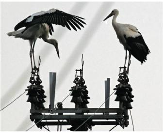
Fig. 33: C'est en ouvrant les ailes, en se chamaillant ou en saisssant les fils avec le bec que les cigognes s'électrocutent. Miécourt, 17 août 2011.
