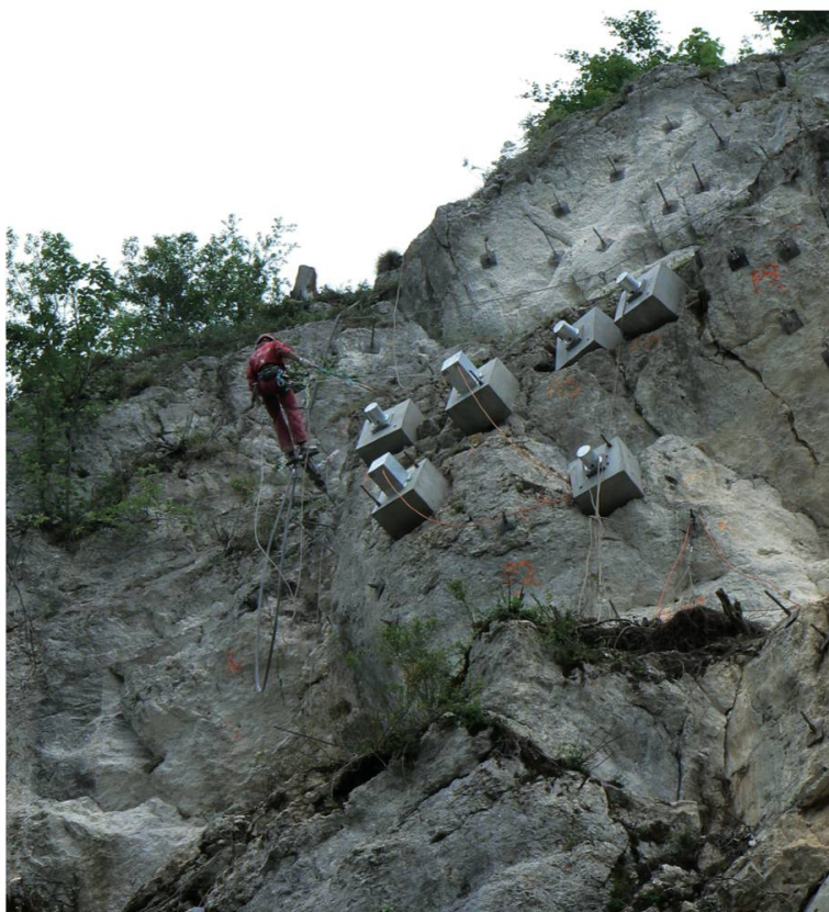
Figure 10: «jumeau», les six ancres à droite de l'ouvrier, avec leurs appuis en béton, sont bien visibles depuis la H18; on peut également observer, à droite et au-dessus, les têtes de clous (petites plaques carrées en acier).
