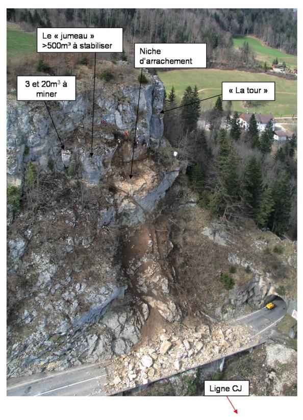
Figure 2: la niche d'arrachement et l'accumulation sur la H18 à 1'ouest du tunnel de La Roche (hélicoptère 20.03.2008).
