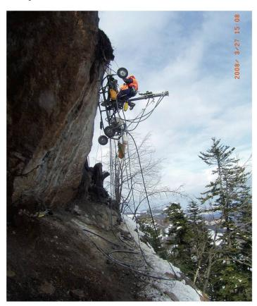
Figure 8: forages pour les clous dans la niche d'arrachement
