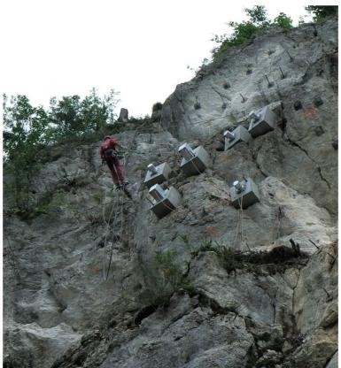
Figure 10: «jumeau», les six ancrages à droite de l'ouvrier, avec leurs appuis en béton, sont bien visibles depuis la H18; on peut également observer, à droite et au-dessus, les têtes de clous (petites plaques carrées en acier).
