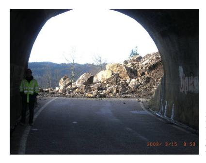
Figure 3: l'accumulation des 200 m³ de blocs calcaires sur la H18 (vue vers l'ouest depuis l'intérieur du tunnel de la Roche).
