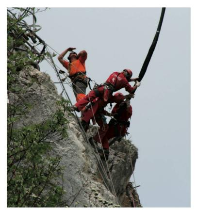
Figure 9: «jumeau», mise en place des tirants d'ancrage en falaise à trente mètres au-dessus de la H18, à l'aide de l'hélicoptère.
