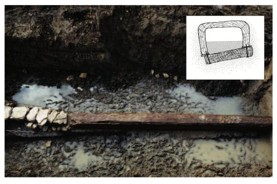
Fig. 7: Vue et coupe de la conduite en sapin. Dessin et photo P.-A. Borgeaud.
