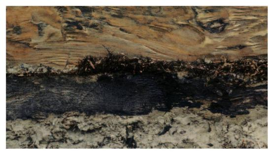
Fig. 8: Détail du joint de mousse. Photo P.-A. Borgeaud.
