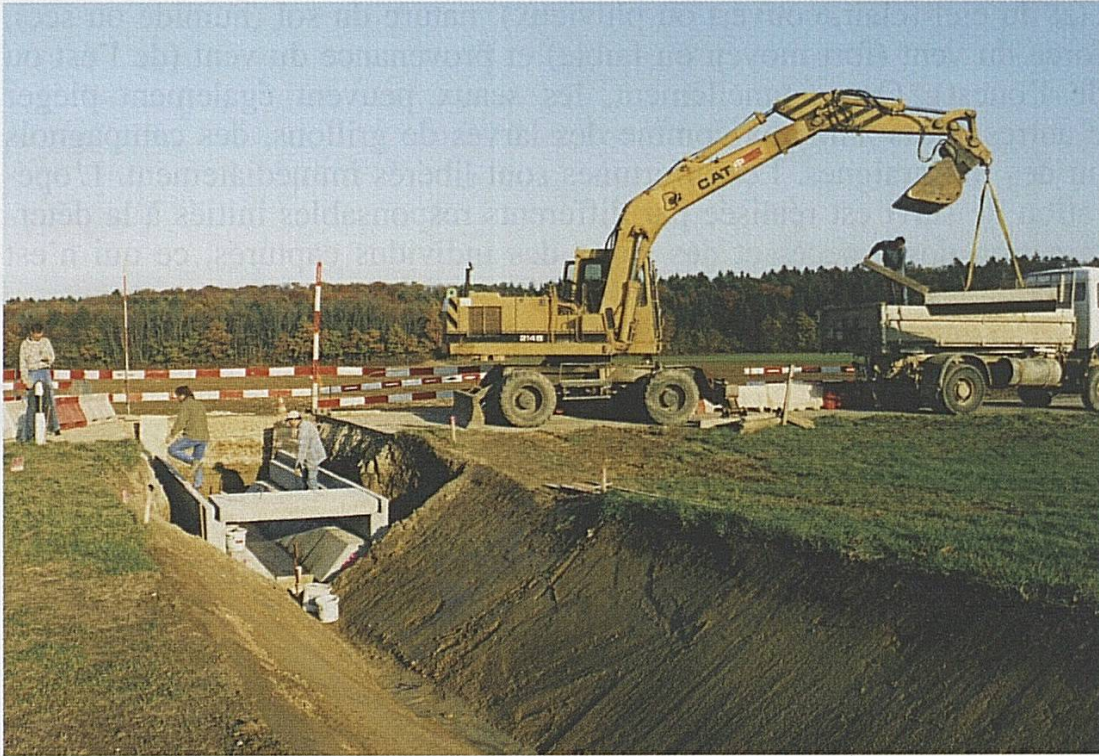
Fig. 7: Le 5 novembre 2003, mise en place d'un canal à petite faune sous la route cantonale Cœuve-Damphreux. Ce «crapauduc», aux dimensions adéquates, s'est révélé fonctionnel pour les Batraciens au printemps 2004.
