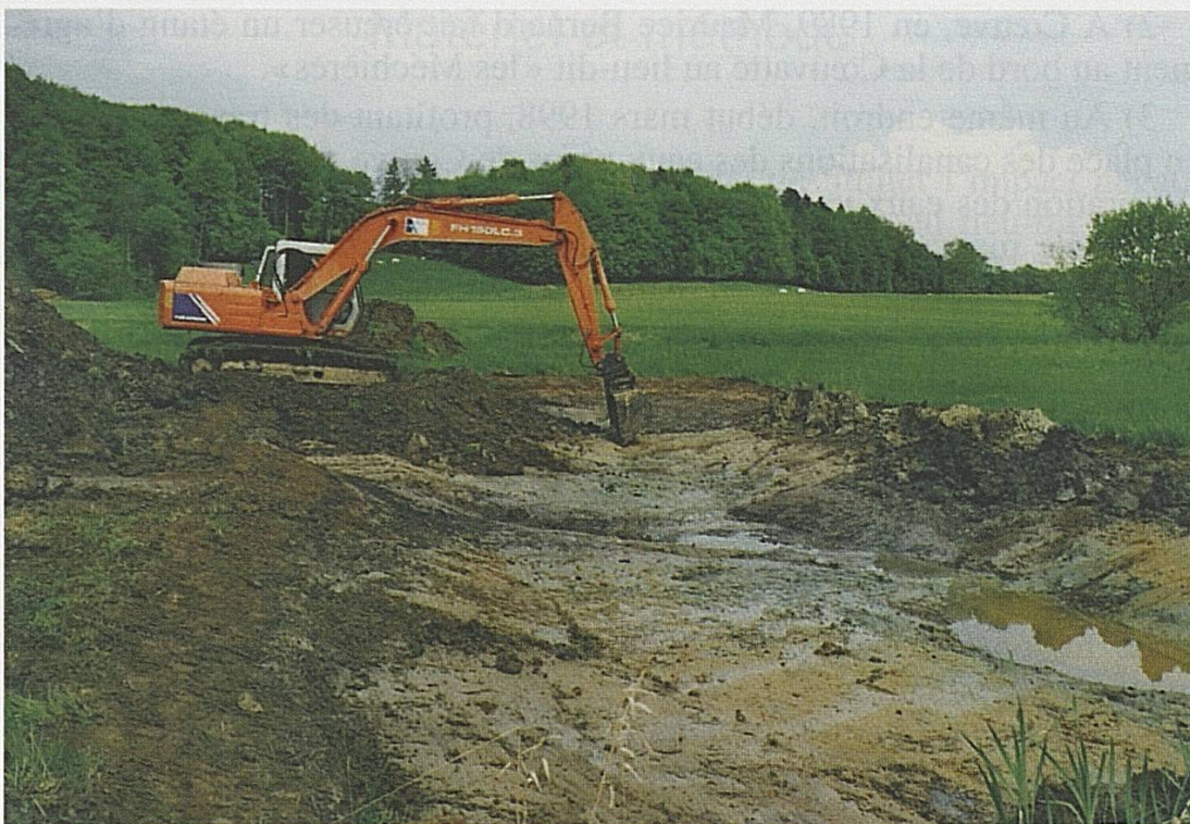
Fig. 4: Le 4 mai 2000, une mare asséchée est réaménagée dans le secteur des «Méchières» à Cœuve. Un ancien lit de la Cœuvatte est visible au centre du creusage, au niveau du terrain qui apparaît en noir en raison de la présence de terre tourbeuse. D'anciennes canalisations en bois ont été retrouvées. De nos jours, à cet endroit, la Cœuvatte coule dans un profond canal rectiligne, à l'ouest du terrassement.
