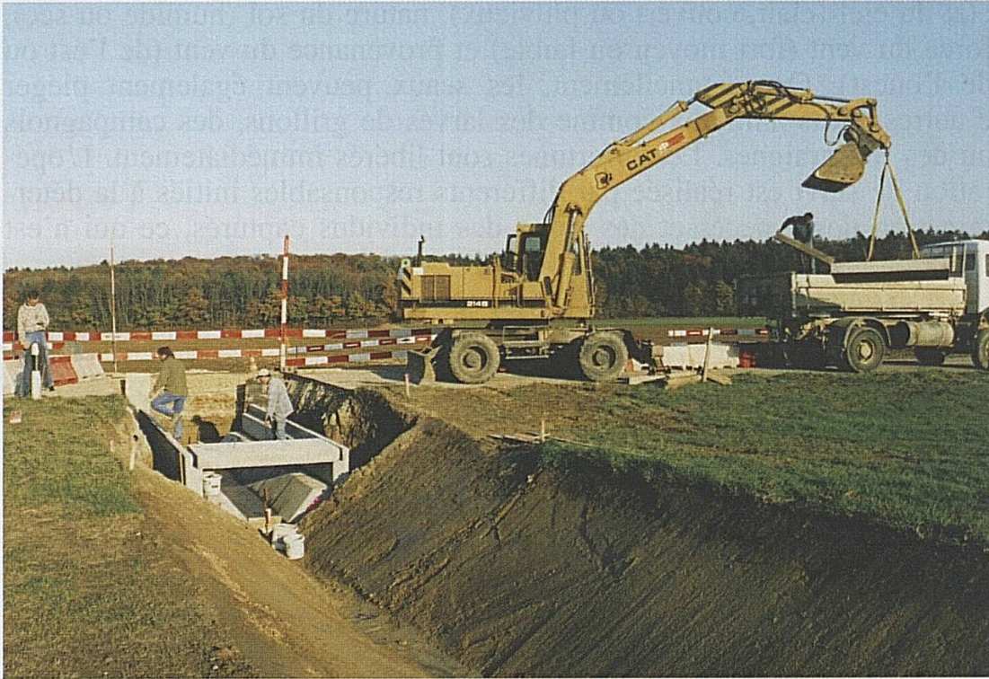
Fig. 7: Le 5 novembre 2003, mise en place d'un canal à petite faune sous la route cantonale Cœuve-Damphreux. Ce «crapauduc», aux dimensions adéquates, s'est révélé fonctionnel pour les Batraciens au printemps 2004.
