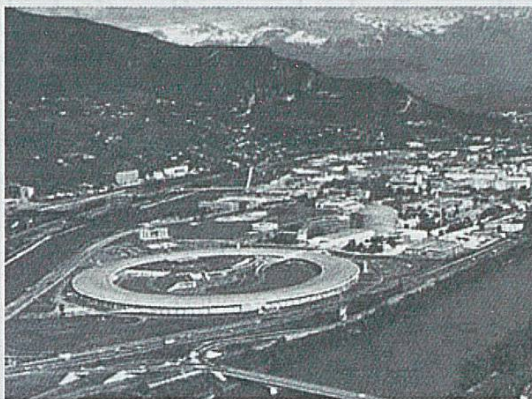
Figure 6: Photographie de l'anneau de stockage de l'European Synchrotron Radiation Facility (ESRF) à Grenoble où ont eu lieu les expériences présentées dans ce travail.
