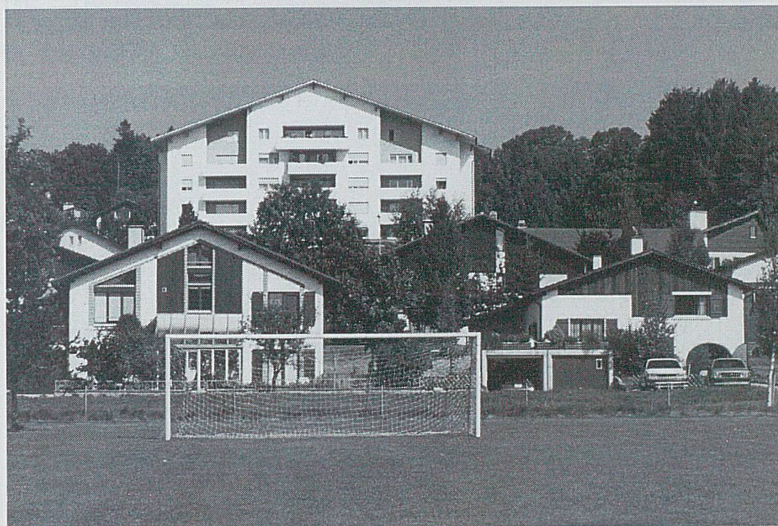
Rupture d'échelle au Noirmont.
