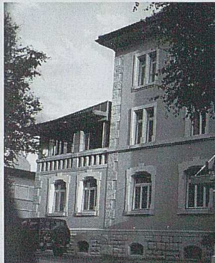
Sauvegarde d'immeubles anciens et adjonction d'annexes à Saint-Imier et Delémont.
