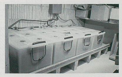
Photo 3: L'électricité doit être stockée à l'aide d'accumulateurs, puisque production et consommation sont différées.
