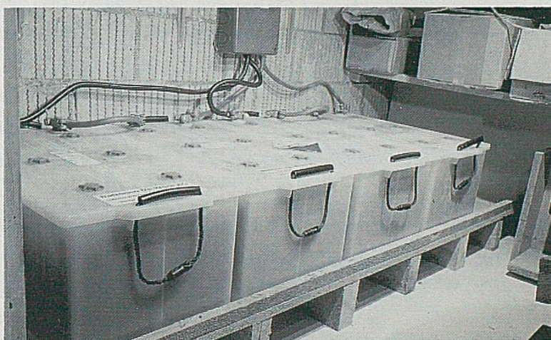
Photo 3: L'électricité doit être stockée à l'aide d'accumulateurs, puisque production et consommation sont différées.
