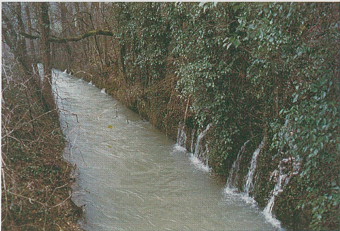
Photo 2 - Venues d'eau en rive gauche (W) du canal de Bellerive lors de la crue du 28 mars 1988.
