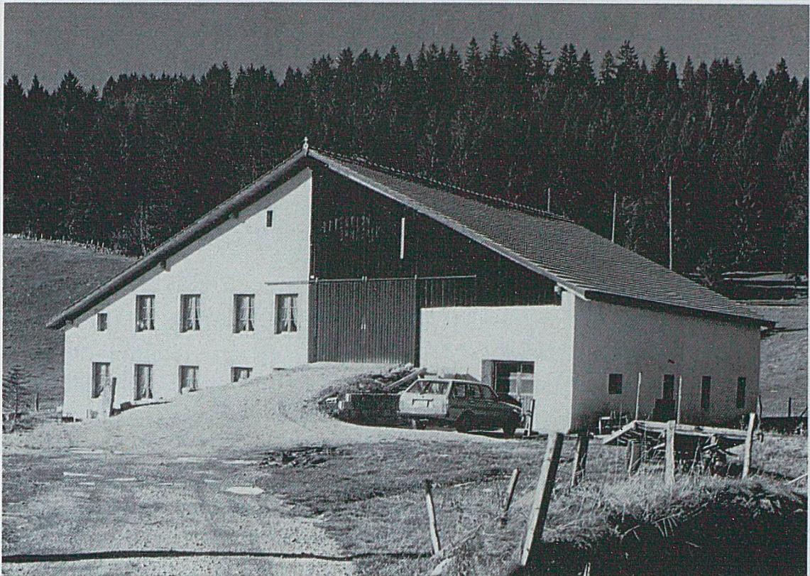
La ferme à quatre pans est, paradoxalement, la plus simple à construire: une structure de poteaux uniformément répartis, supportant des pannes sur lesquelles reposent très simplement les chevrons. Les pannes forment des ceintures horizontales qui sont sur plan carré, donc relativement stables avant et après le montage.
