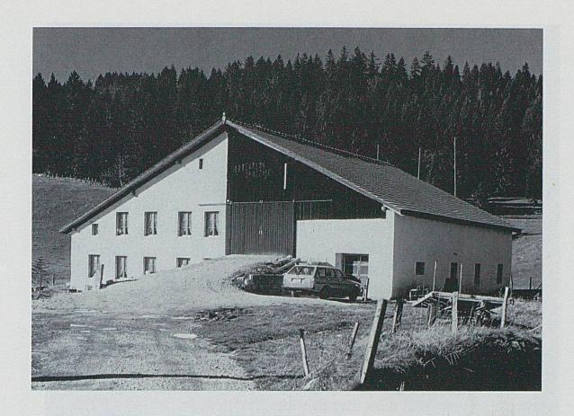
La ferme à quatre pans est, paradoxalement, la plus simple à construire: une structure de poteaux uniformément répartis, supportant des pannes sur lesquelles reposent très simplement les chevrons. Les pannes forment des ceintures horizontales qui sont sur plan carré, donc relativement stables avant et après le montage.
