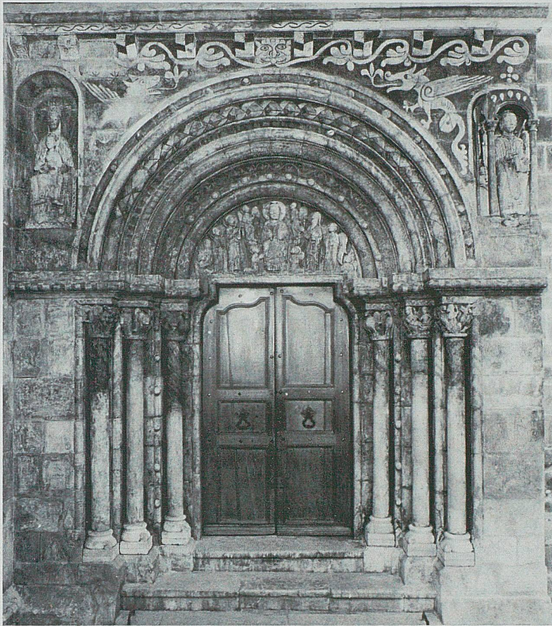
Aspect après les travaux de conservation et de restauration de 1981-1982. (Photo J. Bélat, Porrentruy.)
