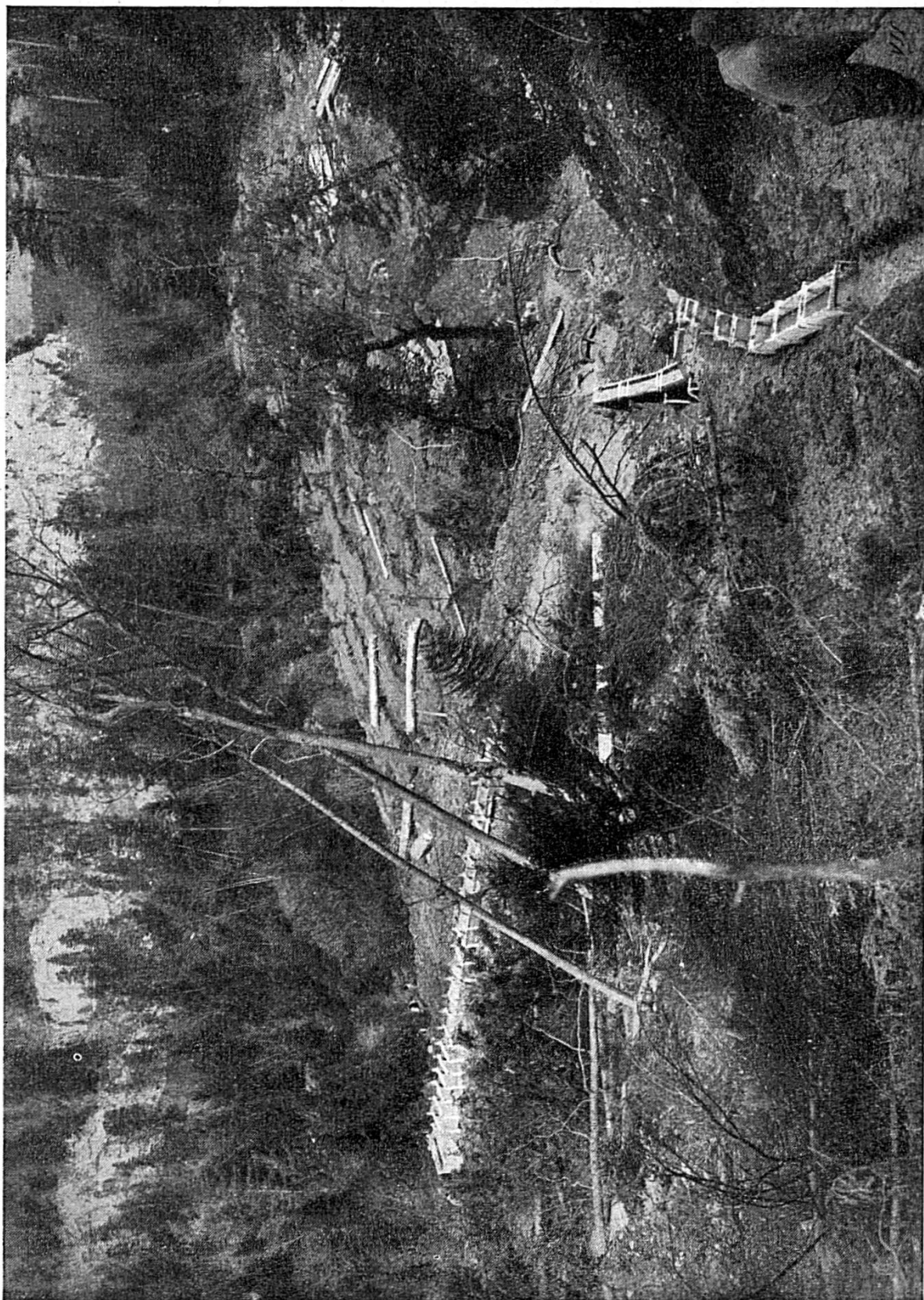
Le glissement avec les canaux d'évacuation
